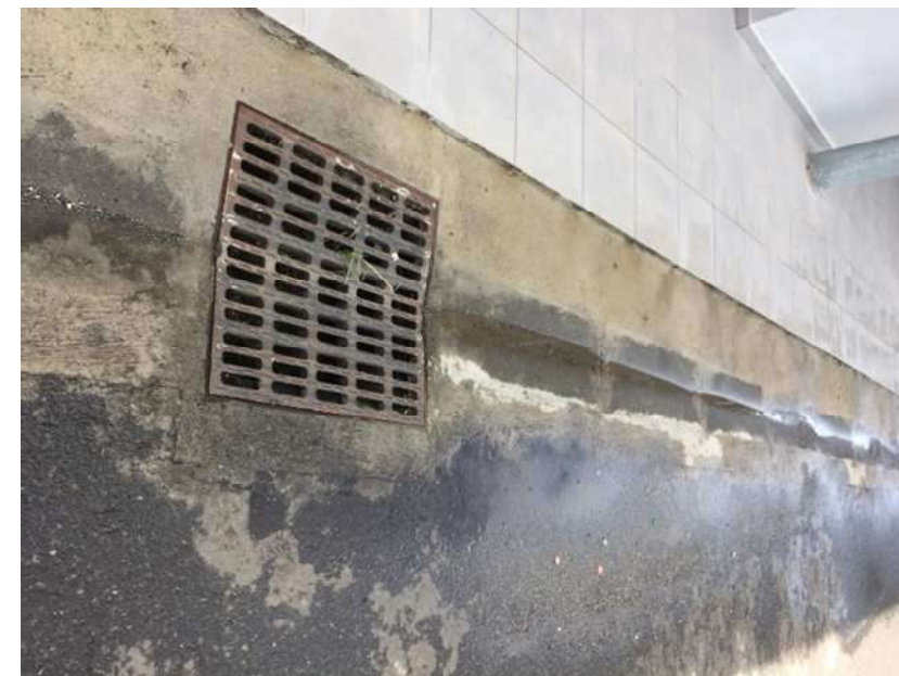
Figure 112 : Récupération des eaux de pluies au niveau des parkings du crématorium (photographie : Egis, 2018)
