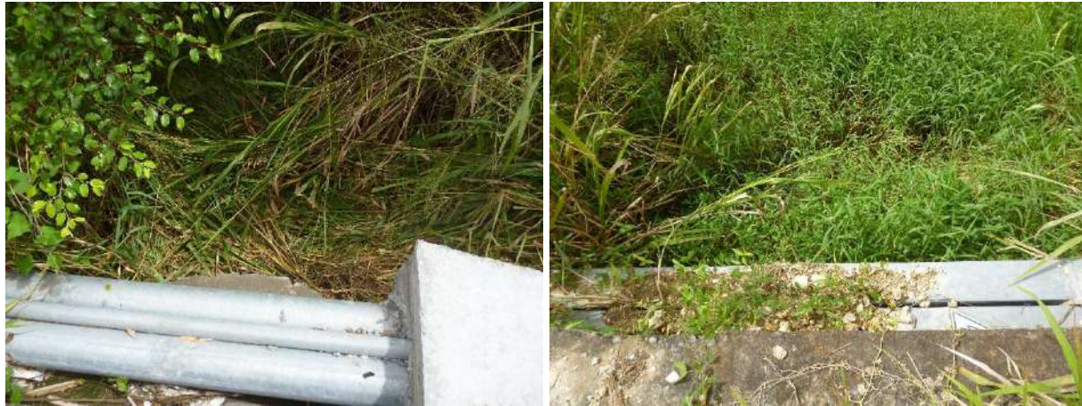
Figure 61 : Amont et aval de l'ouvrage de franchissement de la ravine Nord au Nord-Est de la zone du projet (photographies : Egis, 2018)
