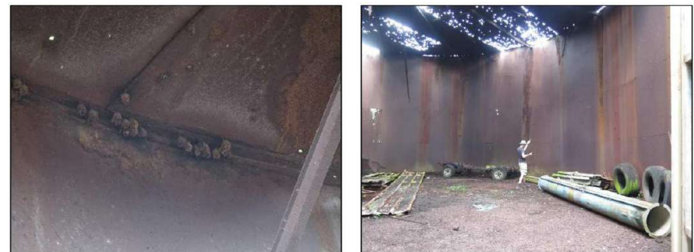
Figure 99 : A gauche : Artibeus jamaicensis suspendus à la toiture de la cuve – A droite : Prospection terrain au sein de l'ancienne cuve
