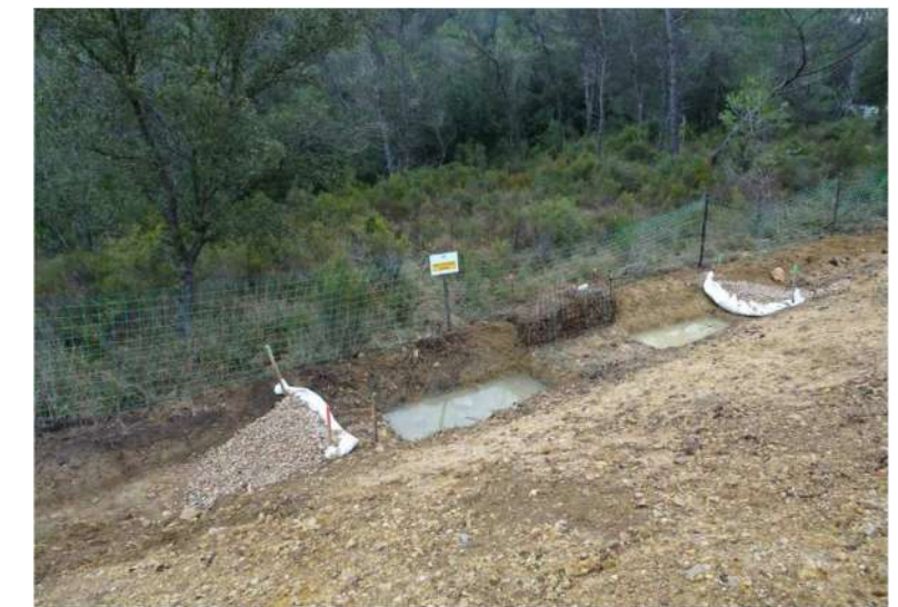
Figure 147 : Fossés de traitement et filtre à paille (source : Egis, 2017)
