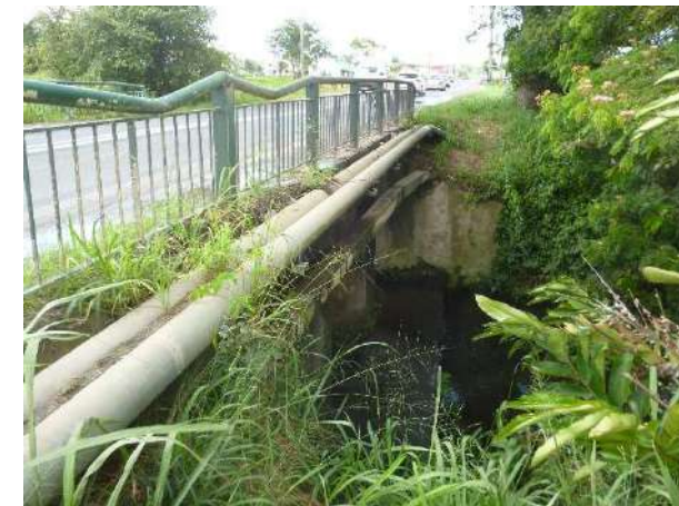
Figure 59 : Aval de l'ouvrage de franchissement de la ravine des Coudes au niveau de la RN5 (photographie : Egis, 2018)
