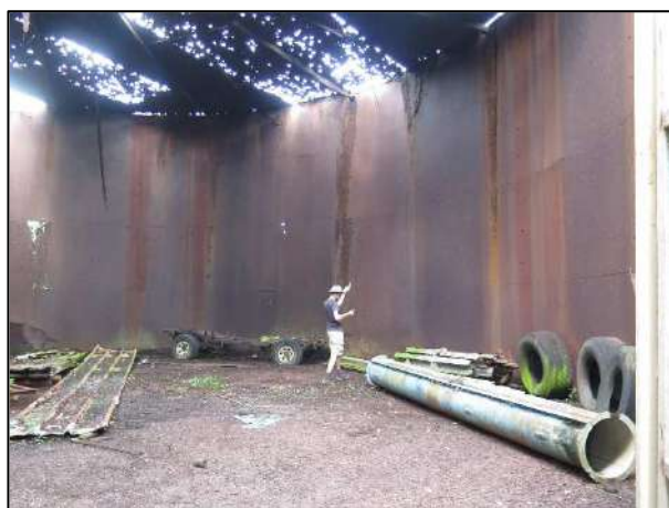
Figure 44 : Prospection terrain au sein de l'ancienne cuve
