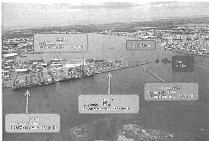
Figure 1. Nouvelle configuration des travaux du quai 12
