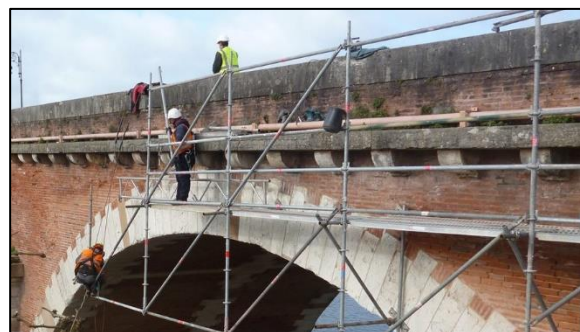
Figure 103: Échaffaudage en encorbellement (Source: https://www.ladepeche.fr/ )
