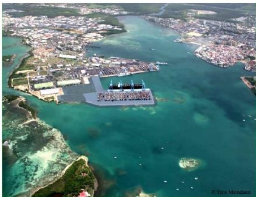
Figure 9 : Vues aériennes obliques du projet de terre-plein de 10ha (Source : Caraïbes Paysages)
