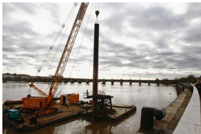
Figure 32 : Schématisation et exemple de mise en place de pieux par barge (Source : Egis Ports, 2016)
