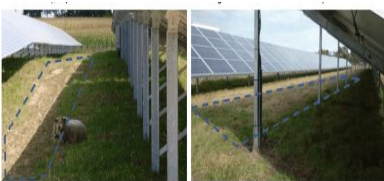
Figure 45: Protection des modules contre le dessèchement de la végétation en période de sécheresse
