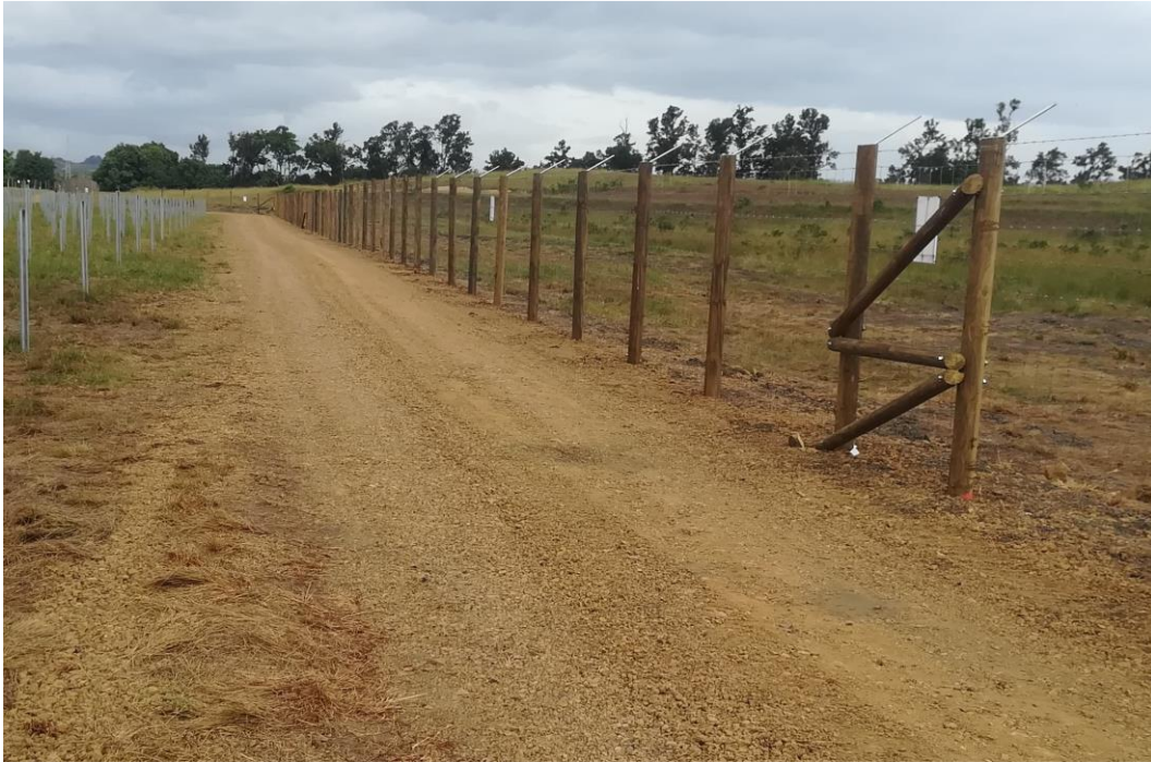
Figure 10 : Exemple de clôture d'enceinte d'une centrale solaire photovoltaïque au sol couplée à un projet d'élevage agricole
