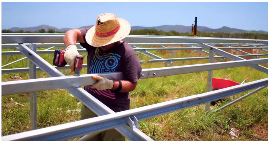
Figure 104 : Exemple de structure en cours de montage (Source : Melvan)
