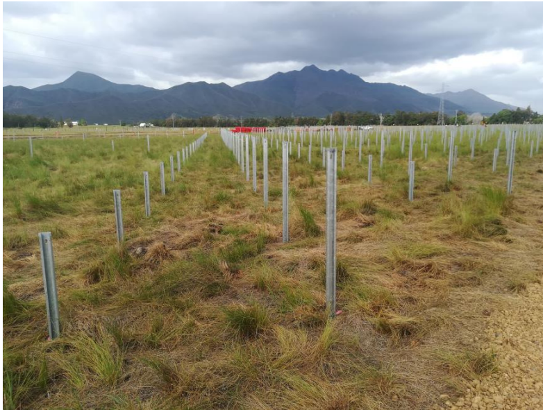
Figure 103 : Illustration de pieux battus avant montage des structures (Source : Melvan)
