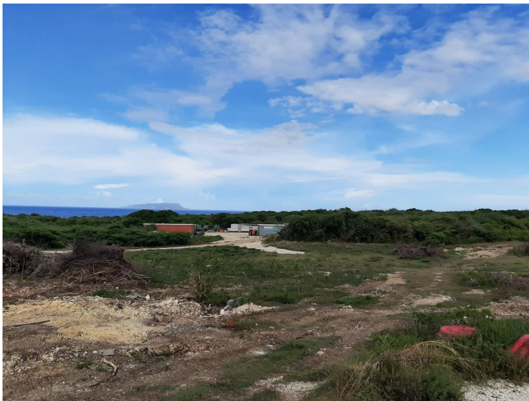
Figure 81 : Préparation du terrain en vue de la construction des nouvelles éoliennes
