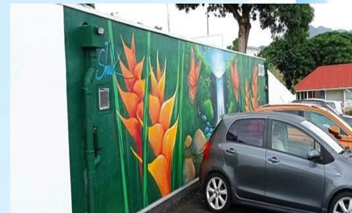
Construction de la bâche à eau semi-enterrée du CHBT Réception des travaux fin octobre 2020
