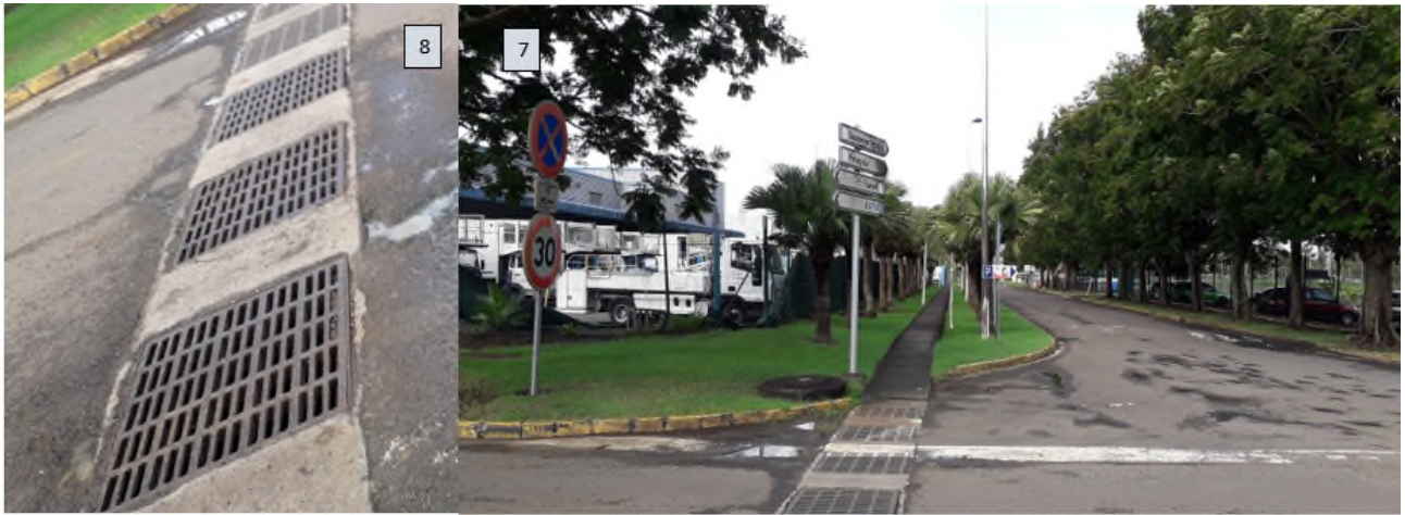
Figure 5 : Ouvrages hydrauliques présents sur le réseau structurant
