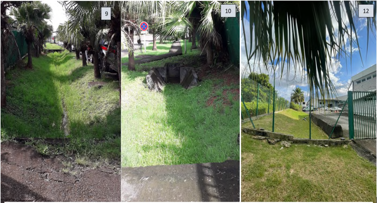
Figure 7 : Ouvrages hydrauliques présents sur le réseau structurant-2
